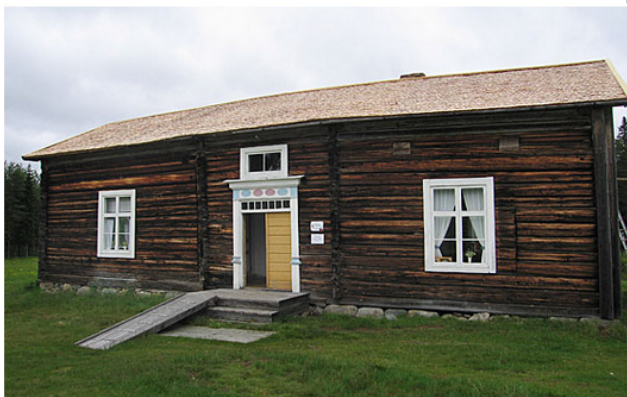
Рис. 1 Кровля из дранки в Рисмирлидене (Rismirliden). https://hallahus.se/renovera/taket/spantak/
