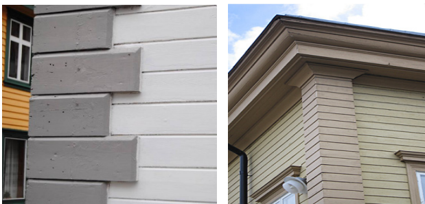
Рис. 2. Деталь деревянного руста (слева), деталь карниза и углового руста типичного здания в стиле ампи́р (справа). https://hallahus.se/stilhistoria/1790-1850/empire/
