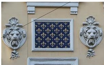
Фото 9 - Фрагмент фасада доходного дома А.А. Кушелева, Римского-Корсакова пр., 1, арх. Носалевич А.И., 1899-1900.
