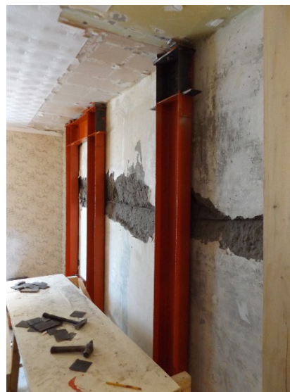
Рисунок 5. Монтаж стоек усиления аварийной стеновой панели
